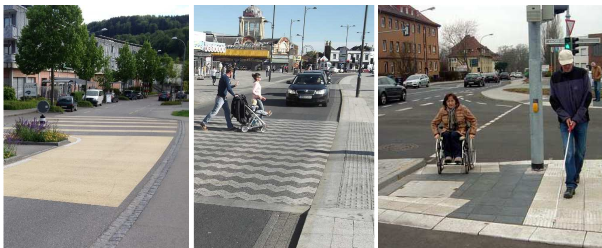
Abb. 18, 19, 20: Straßenquerung gekennzeichnet durch farbige Bereiche; gepflasterte, taktil wahrnehmbare Straßenquerung; Differenzierte Bordhöhen am Übergang für Geh- und Sehbehinderte
