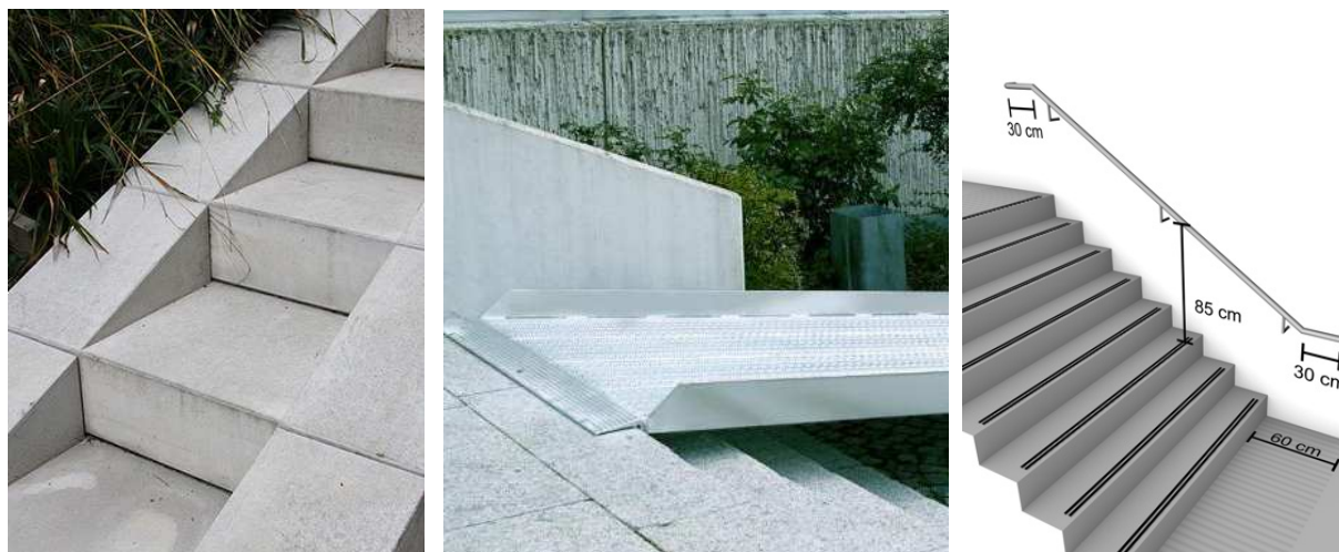
Abb. 13, 14, 15: Nicht barrierefreie Kinderwagenrampe, Rollstuhlgeeignete Rampe, barrierefreie Treppe
