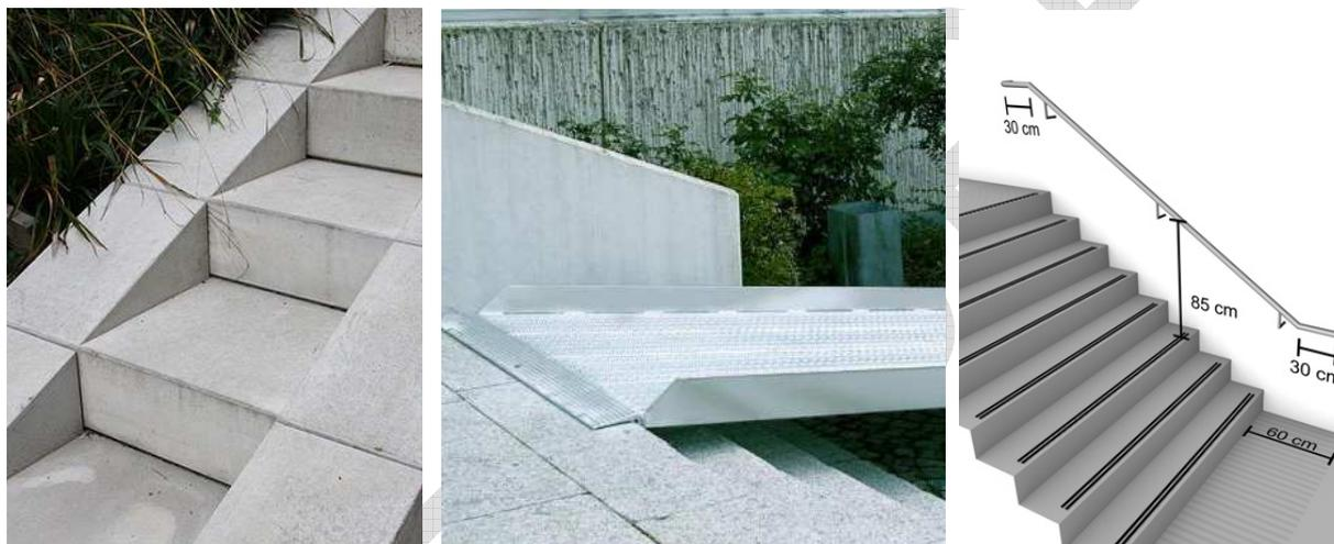
Abb. 13, 14, 15: Nicht barrierefreie Kinderwagenrampe, Rollstuhlgeeignete Rampe, barrierefreie Treppe
