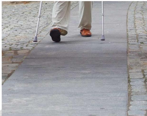
Abb. 16, 17: Die barrierefreie Gestaltung von Teilbereichen in Natursteinpflaster ermöglicht eine barrierefreie Fortbewegung
