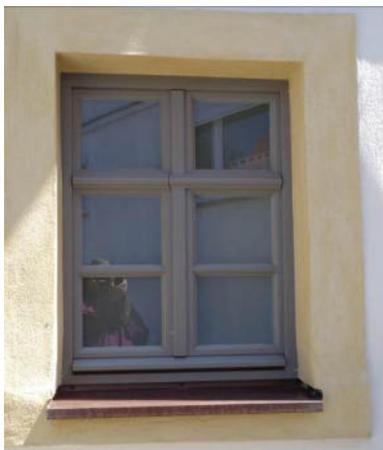
Später wurde das Oberlicht aus zwei Flügeln zu einem Flügel zusammengefasst und als Kippflügel ausgeführt. Bauphysikalisch waren allerdings zwei Drehflügel besser als ein Kippflügel.
